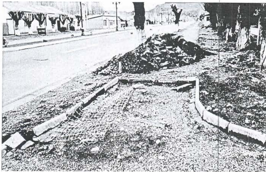
Fotografía N os 62 y 63: Solerillas sin emboquillado.
