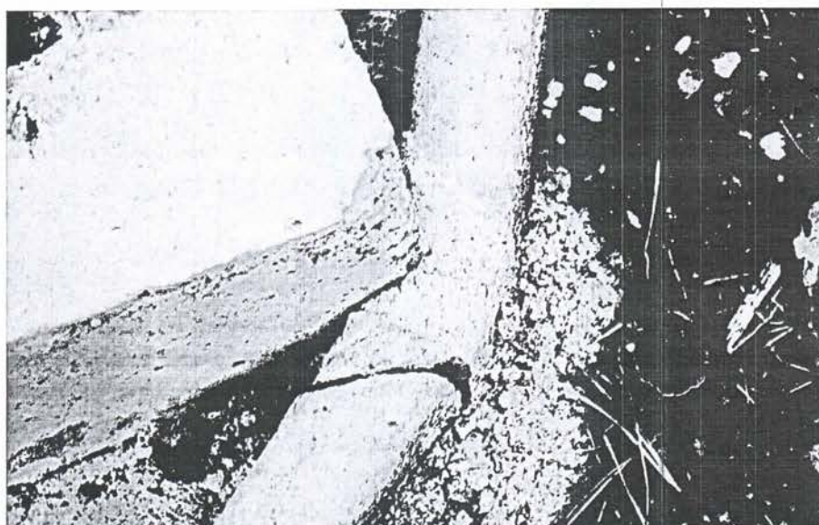
Fotografías N os 43 y 44: Excesiva separación en pavimentos.
