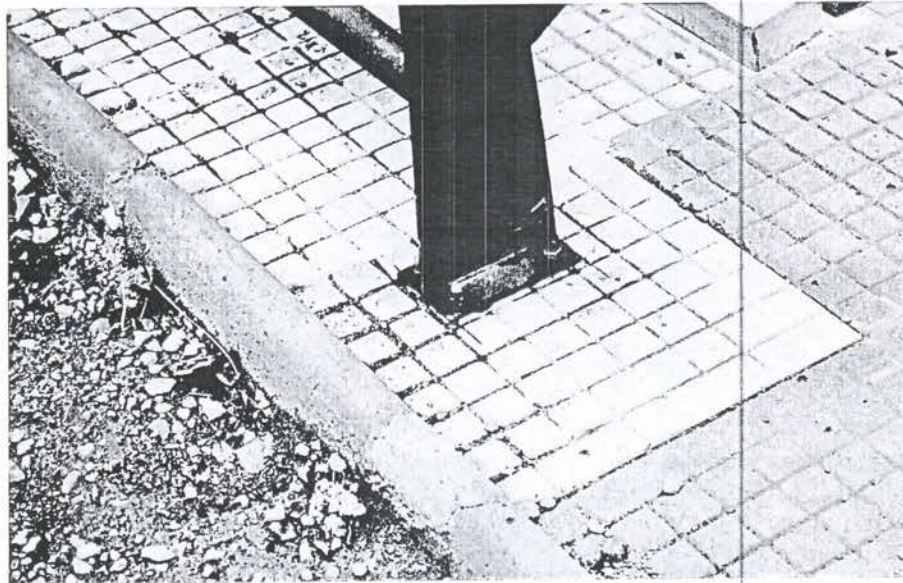
Fotografía N°s 19 a 28: Deficiencias en anclajes de escaños.
